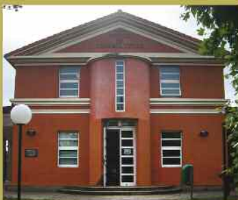
Antiga escola de Curtis. Funciona como edificio de usos múltiples
