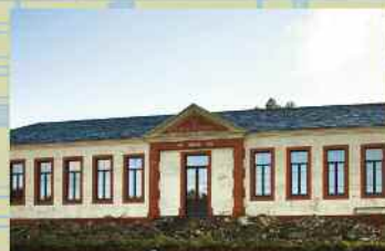
Escola da Avspelra, A Barqueira, Cerdido, 1932
