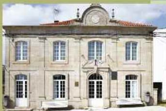
Casa-escola da Bandeira, Silleda, 1930
