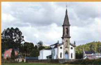
Torre da igrexa de San Claudio, Ortigueira
