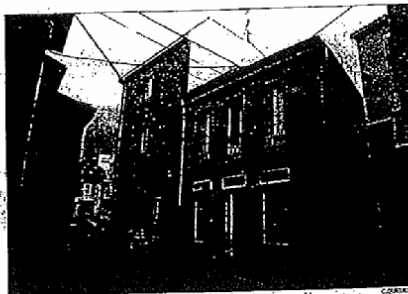
El establecimiento hostelero y la vivienda del denunciante, según denunciado por una pared por un vecino de Rianxo.
