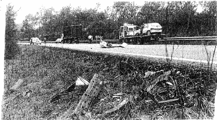
La zona de las llamadas curvas de Vilas es uno de los puntos más conflictivos y que está previsto eliminar con la autovía
